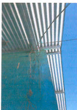
Foto 3: MEJORAMIENTO GENERAL DE REPARACION DE SISTEMA ELECTRICO
