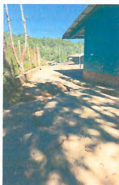
Foto 1: MEJORAMIENTO DE LOSA DE PATIO
