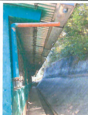
Foto 2: MEJORAMIENTO GENERAL DE CANALES Y BAJADAS DE AGUA PLUVIAL
