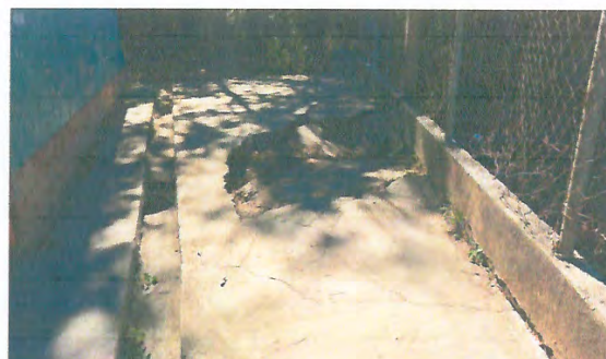
Foto 4: MEJORAMIENTO DE LOSA DE PATIO
